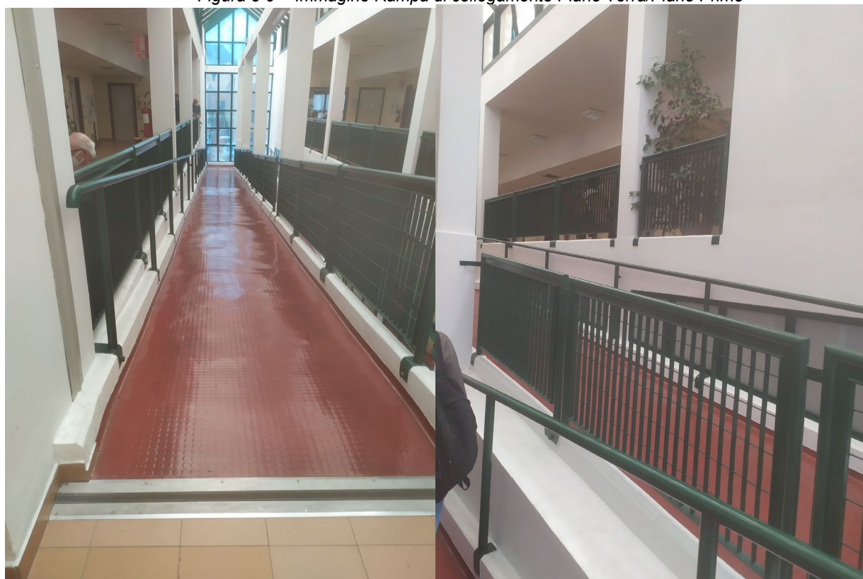
Figura 10-11 - Immagine Rampa di collegamento Piano Terra/Piano Primo
