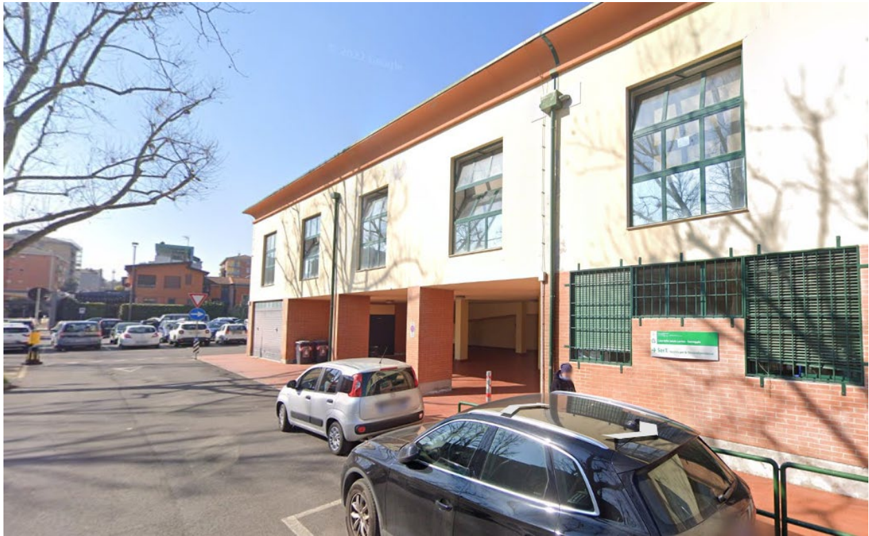
Figura 4 Immagine esterna Via Mameli – Portico oggetto di intervento
